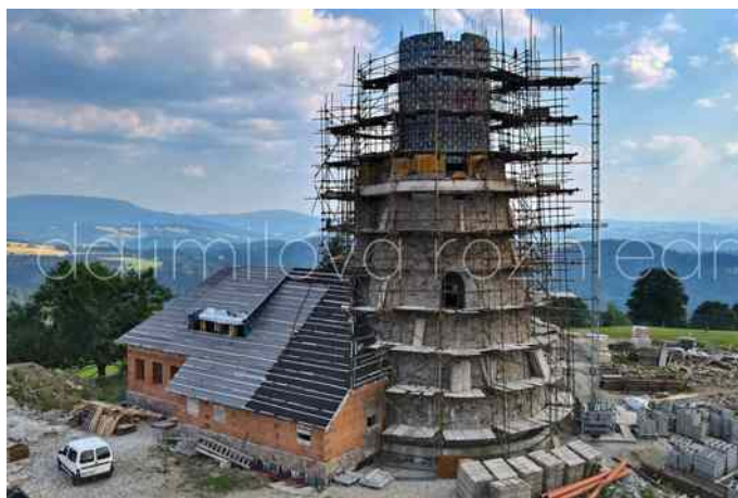
Stand der Arbeiten im August 2020 (Foto: dalimilovarovzhledna.cz)
